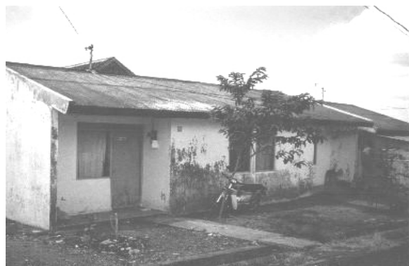
Type 21 Perumahan Dalung Permai Sumber: Dokumentasi Pribadi , 1998.
