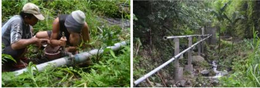
Gambar 12. Foto pengerjaan pipa penerjun/penggerak
