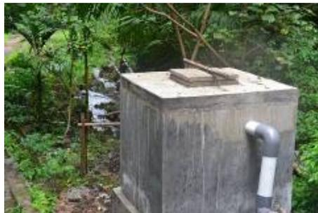
Gambar 11. Foto bak penerjun/penggerak
