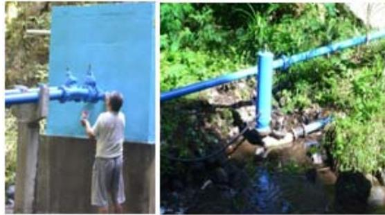
Gambar 19. Foto pengecatan pompa hydran dan pipa penggerak
