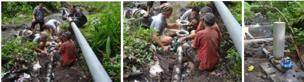
Gambar 13. Foto pengerjaan atau perakitan pompa hidram
